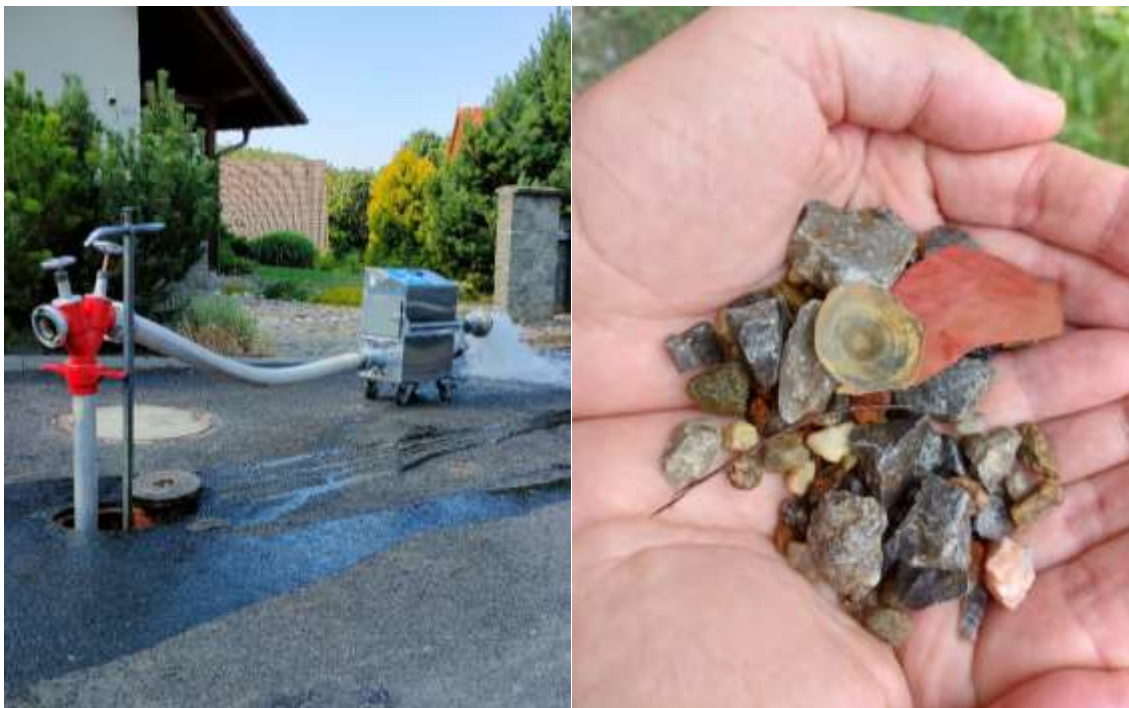
Obr. 3 Doporučený způsob připojení stroje při proplachu vodovodu (vlevo), předměty z vodovodního potrubí, které stroj dokáže bezpečně vypláchnout ven, aniž by došlo k jeho poškození (vpravo).
