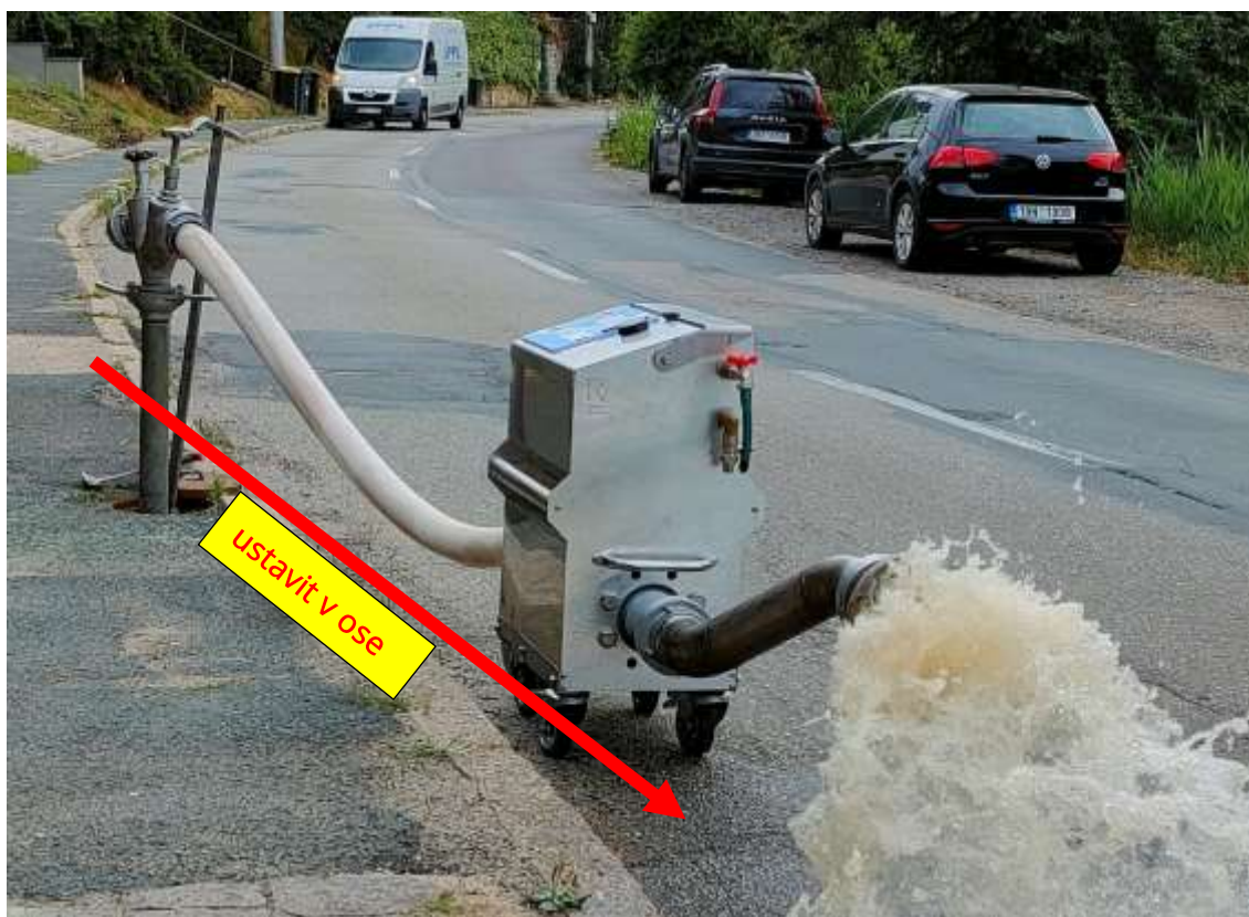
Obr. 4 Správný způsob připojení stroje při proplachu vodovodu. Červená osa znázorňuje správně zapojený hydrant, hadici a stroj. Hadice je mírně prohnutá.
