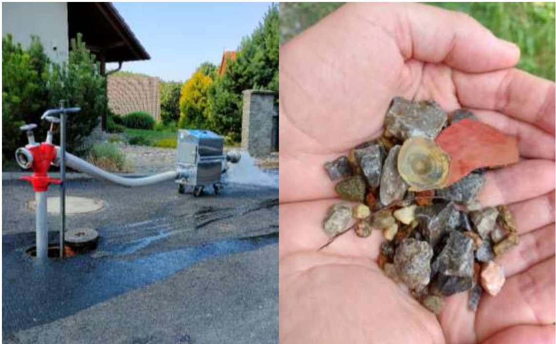
Obr. 3 Doporučený způsob připojení stroje při proplachu vodovodu (vlevo), předměty z vodovodního potrubí, které stroj dokáže bezpečně vypláchnout ven, aniž by došlo k jeho poškození (vpravo).
